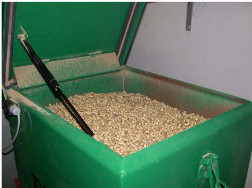
**Der Vorratsbehälter fasst genügend Pellets für zwei bis drei Tage Heizbetrieb. Auch hier könnte eine Förderschnecke für die automatische Nachfüllung sorgen.**
