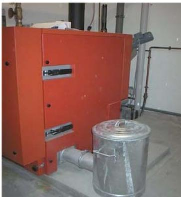
Das Problem des Anbackens der Schlacke an den Brennraumwänden in der **ÖKO THERM-Compact-Anlage** wird auf Grund modernster Verbrennungstechnologie vermieden. Das patentierte Verbrennungssystem arbeitet wartungsfreundlich und verschleißarm.
